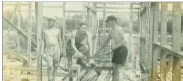
Bau der Baracke
